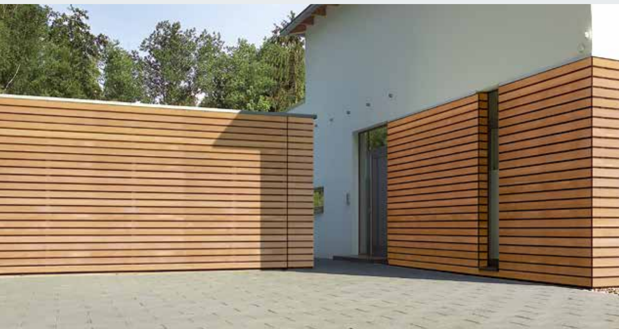
Poszycie z paneli drewnianych wykonane przez inwestora
